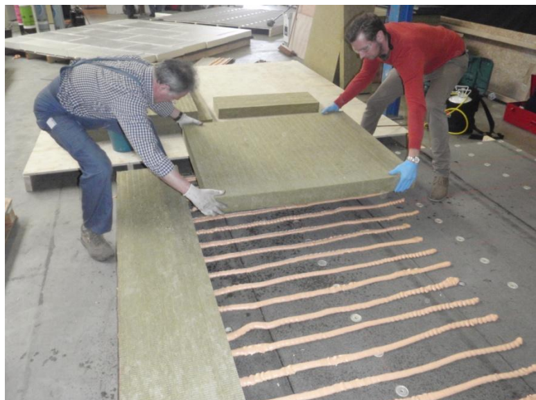
Foto 3 Die Wärmedämmung wird angebracht.
