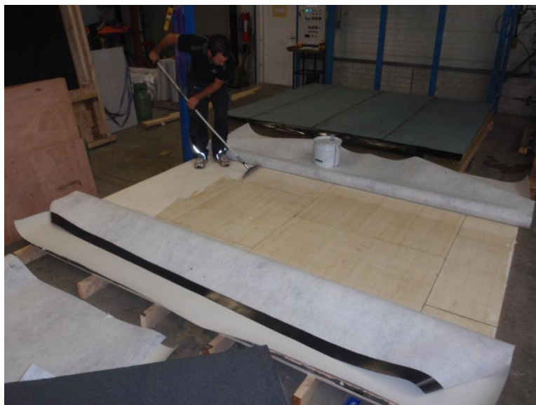
Foto 4 Das Klebermittel wird mit Schmieren angebracht.
